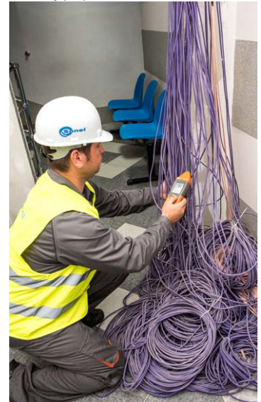
...y el estado directamente antes de su tendido
